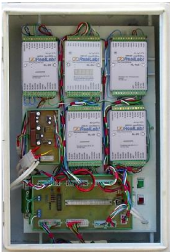
Рис. 6.1. Часть испытательного стенда, смонтированная в шкафу
